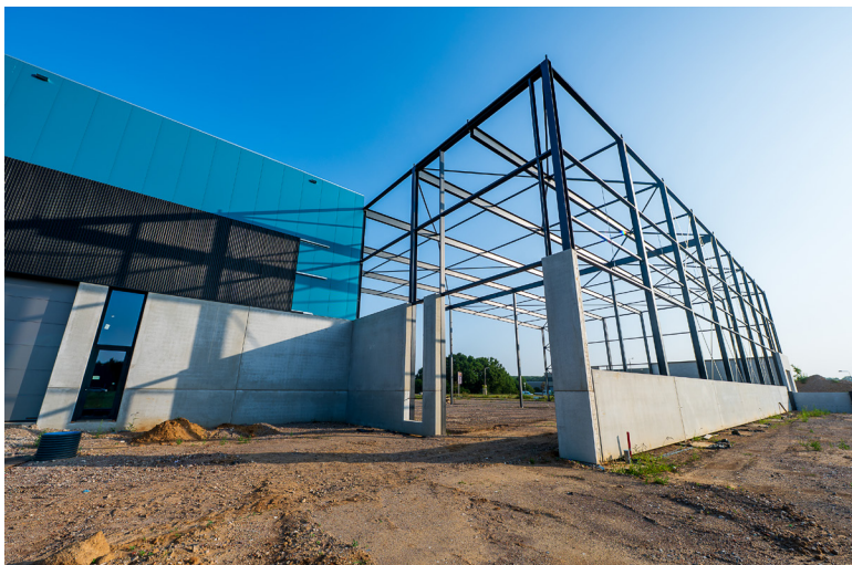
Bedrijventerrein Oosttangent in aanbouw
