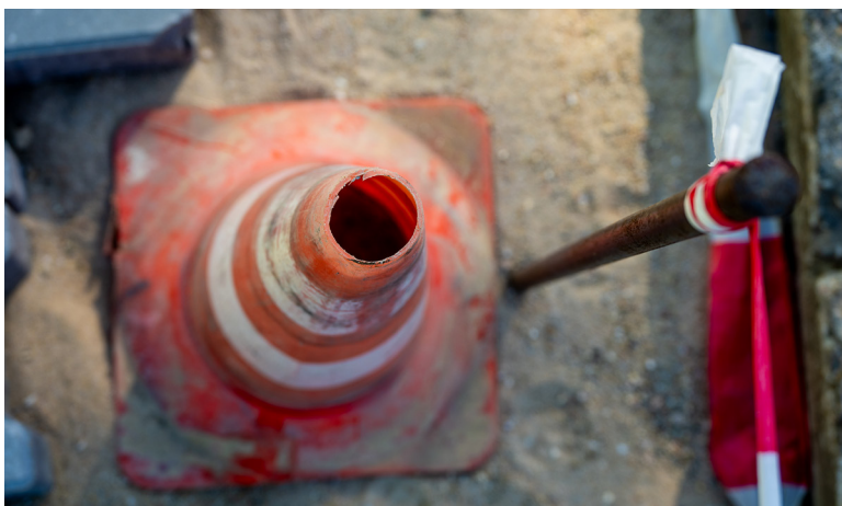
Werkzaamheden in uitvoering
